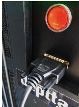
Imagen 11. Instalación del MPG.
